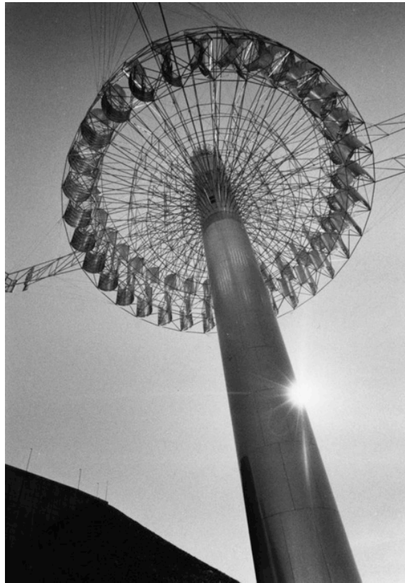
Fig. 10 Torre Solar , 1986, Hierro estructural y acero inoxidable, 50 x 30 m (diámetro externo 50 m). Represa Raúl Leoni, Guri
